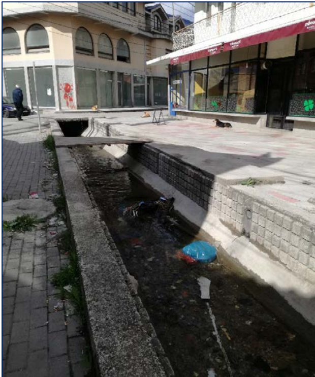
Figura 3-2 Kolektor i hapur në qendër të Pejës
