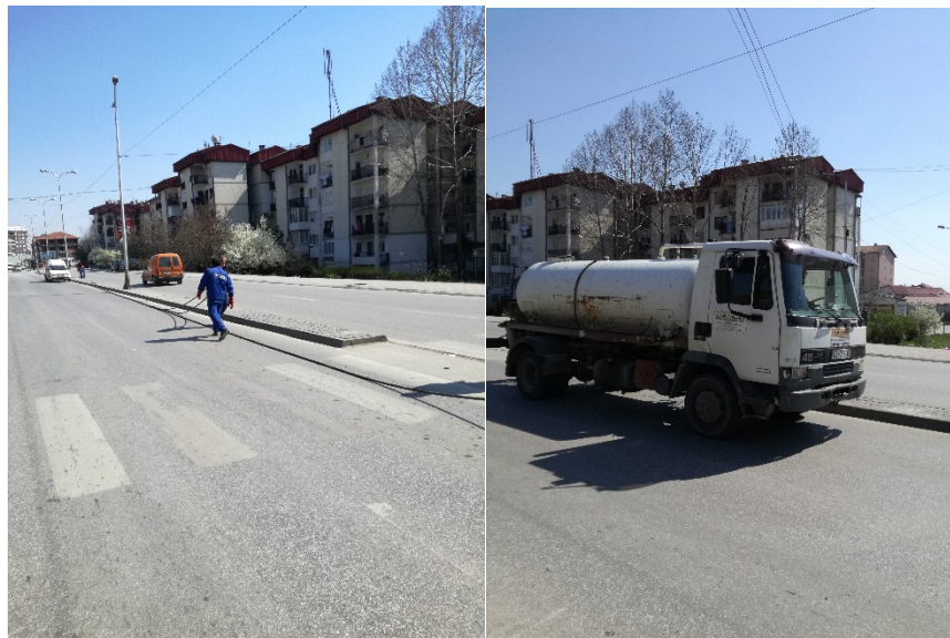
Figura 4-3 Pastrimi i gypave të kanalizimit, autocisternë e kombinuar (presion dhe thithje) në Pejë.
