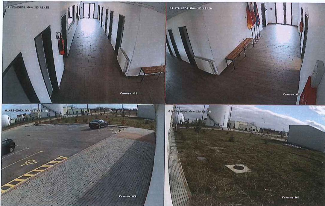
Figura paraqet pamjet nga katër (4) kamerat e instaluar në Impiantin për Trajtimin e Ujërave të ndotura.
